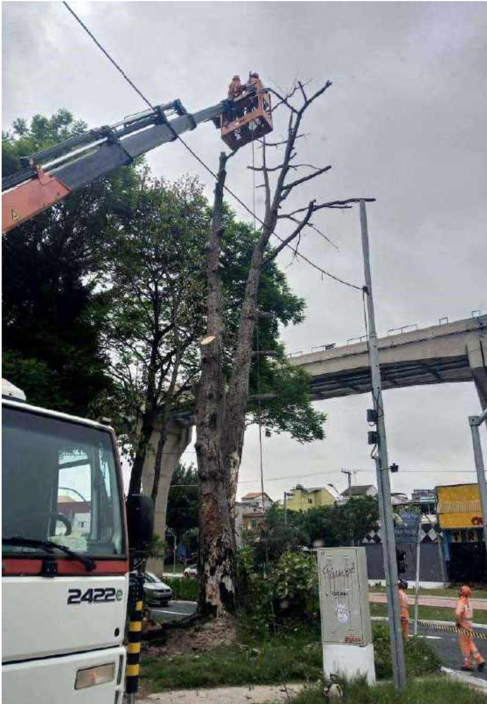
Figura 5: Utilização de plataforma elevatória para remoção de árvore seca.
